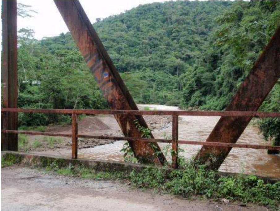
Fotografía N° 10 - Puente Albariño sobre el Río Palcazú en el Sector San Francisco
