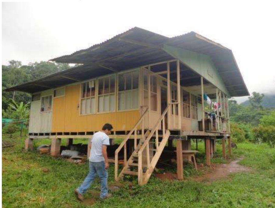
Fotografía N° 17- Ex Oficina del Proyecto Especial Pichis Palcazú, Actual Aula del 2° grado de Educación Secundaria
