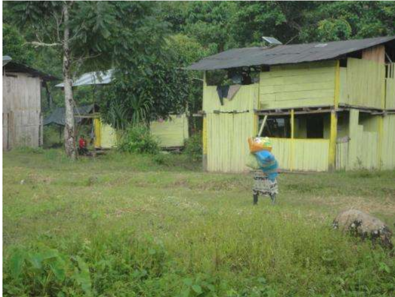
Fotografía N° 26 -Vivienda con su panel solar en el Sector Azulis
