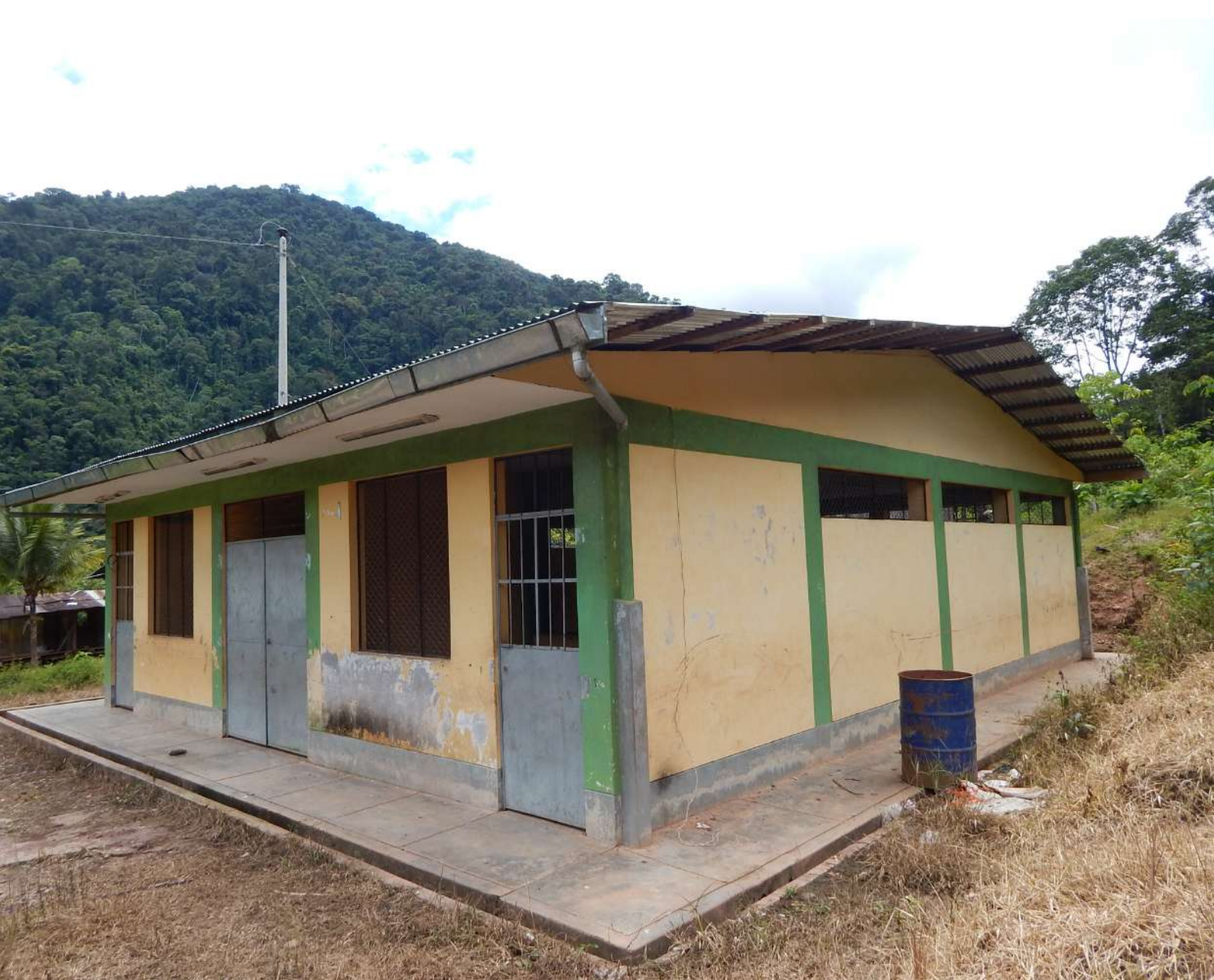
Figura 7: Local comunal de sector de Santa de la CCNN de Santa Rosa de Pichanaz.
